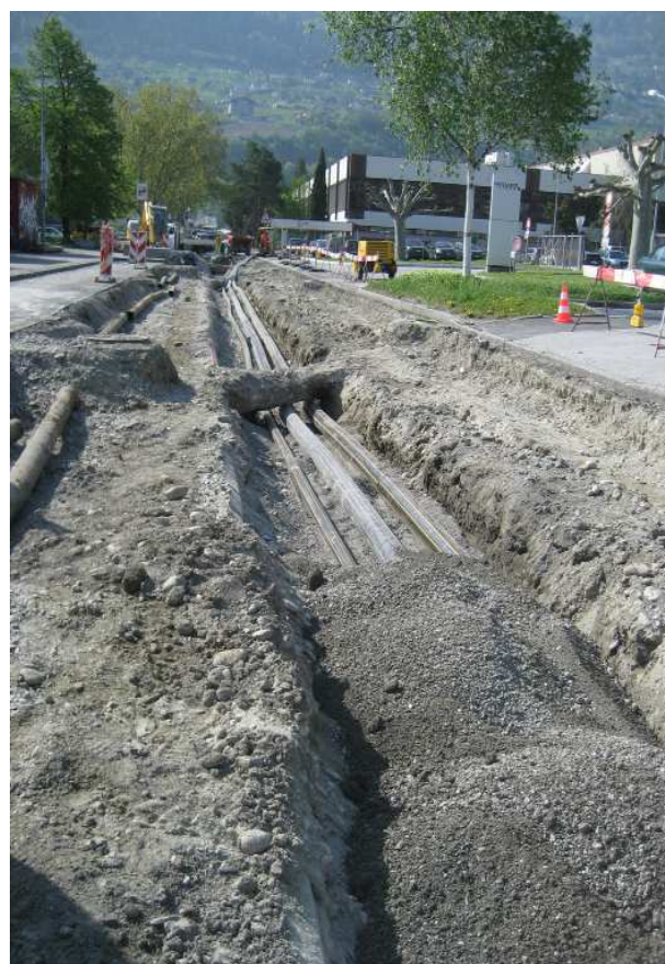
Enrobage de conduites eau + gaz avec matériaux fins
