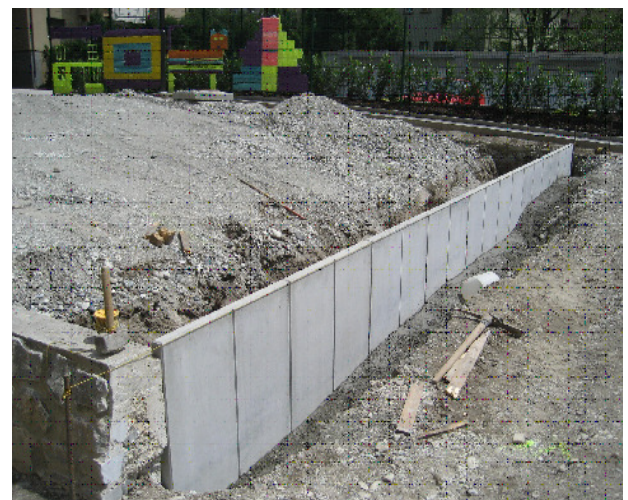
Mise en place d'éléments de soutènement pré-fabriqués
